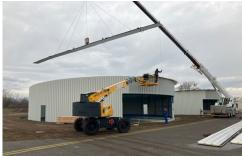
Der Durchmesser, dieses aktuell stark nachgefragten Hallentyps, beträgt jeweils knapp 25 Meter. Auf dem Drehteller jeder Halle finden bis zu acht Flugzeugen der Echo-Klasse Platz. Die große Herausforderung beim Rundhallenbau ist die Genauigkeit, um die Leichtgängigkeit des Drehtellers zu gewährleisten. Diese ist speziell bei diesem Hallentyp mit ca. 75 Meter Umlauf und den gebogenen Stahlprofilen sowie bei den notwendigen Fundamenten schwierig zu erstellen. Wir erreichen das z.B. durch den
